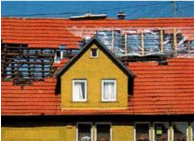
Abb. 17 Teilweise abgedecktes Ziegeldach
